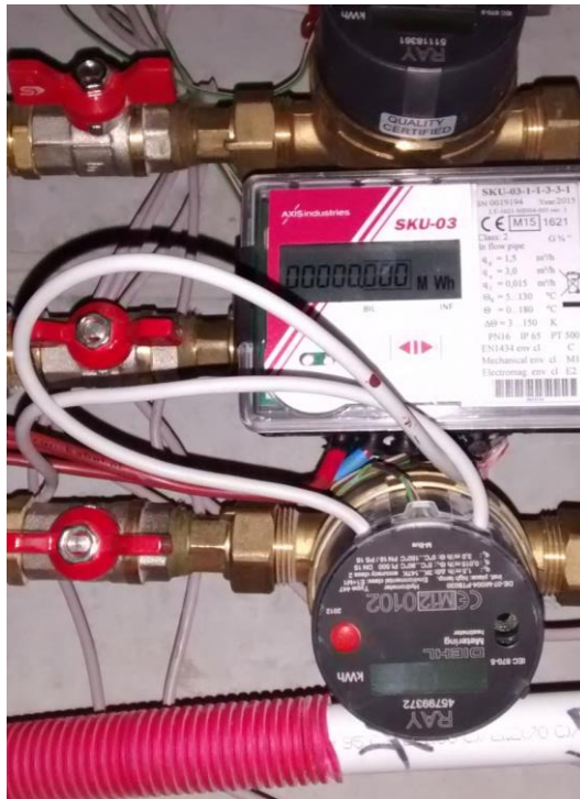
32 pav. Pavyzdinė apskaitos prietaisų duomenų nuotolinio įrenginių nuskaitymo sistema
